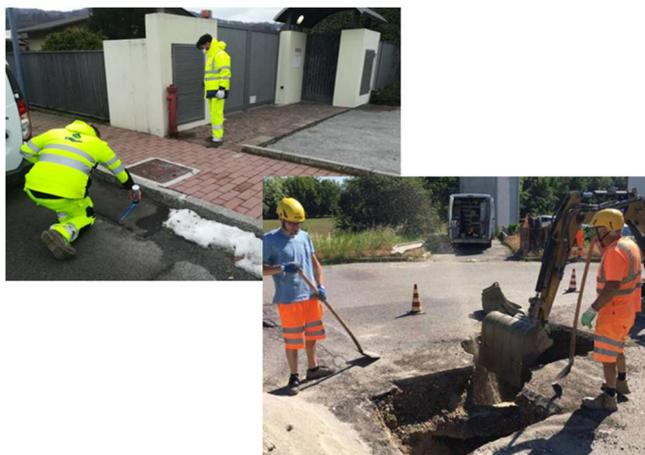
Una volta prelocalizzate, le perdite vanno localizzate puntualmente in campo tramite squadre di ricerca equipaggiate con strumentazione acustica. 2F WATER VENTURE ha utilizzato mediamente due squadre per l'attività di localizzazione perdite in campo.
